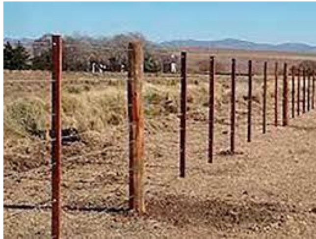
Imagen N° 03. Detalle Cerco Perimétrico
