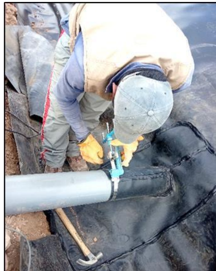
Detalle de unión de tubería con geomembrana
