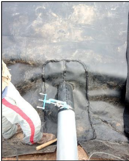
Detalle de unión de tubería con geomembrana
